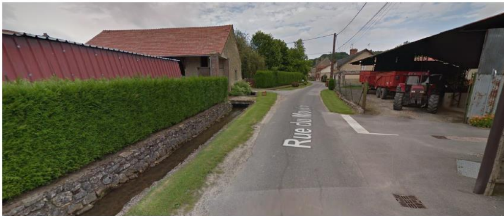
Figure 18 : Rue du Moulin - Etat actuel
